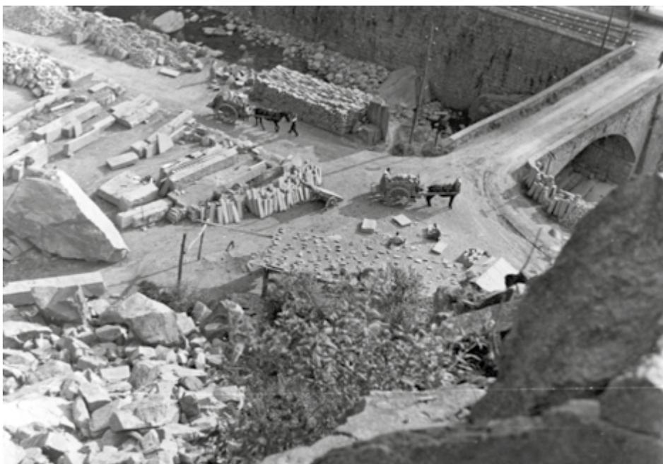
**Vista dall'alto della Cava Antica** con il ponte della Balma e, al di là, i tre binari di incrocio della ferrovia Balma-Biella. La sienite lavorata era ordinatamente accatastata in funzione delle diverse pezzature per essere caricata sui carri trainati da cavalli (gagliotte) che, attraversato il ponte, venivano scaricati e il materiale trasferito sui vagoni che da lì partivano **verso Biella**.
