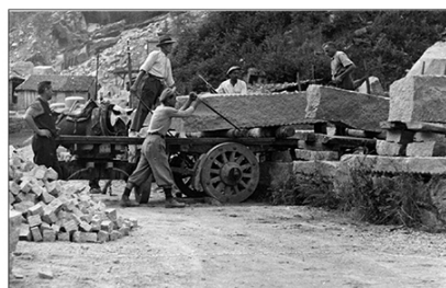
La movimentazione dei blocchi di sienite mediante curli (Archivio privato)
