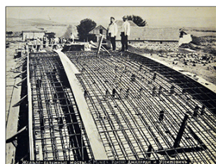
Ponte in cemento armato nei pressi di Tiflis (Russia), 1906-1908 Impresa Pietro Gilardi Magnan (Casa Museo dell'Alta Valle del Cervo)
