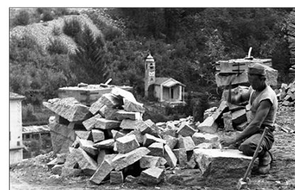
La realizzazione delle plotte e in secondo piano i banchi per il taglio dei cubetti (Archivio privato)
