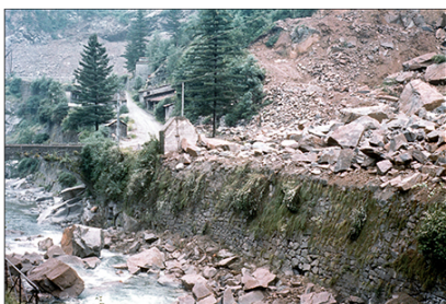
16 Luglio 1980 Vista da monte delle conseguenze dell'esplosione della mina (Archivio Comune di San Paolo Cervo)
